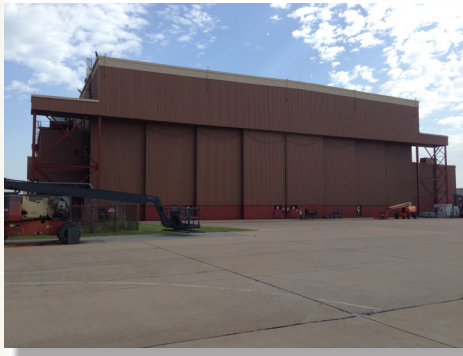
B2280 Repair Hangar Door
